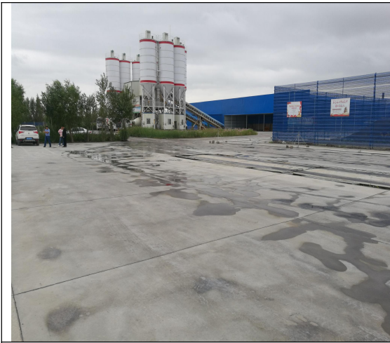
厂区地面硬化
